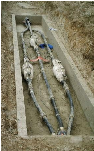
Exemple d'une chambre de jonction pour un circuit à 225 000 volts
