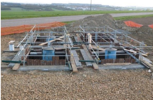
Réalisation des 4 fondations (ci-dessus) et opération de levage d'un support (ci-contre)
