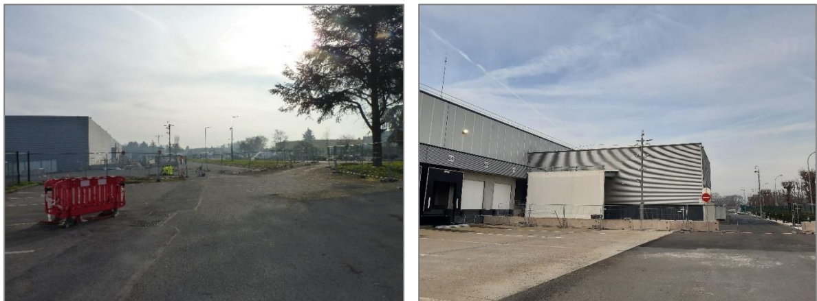
Figure 89 : Voirie et bâtiments, Charlotte GIRONDE, © EODD, 2023
