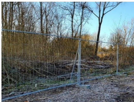
Figure 127 : Exemple d'un balisage type barrière HERAS © EODD, 2022
