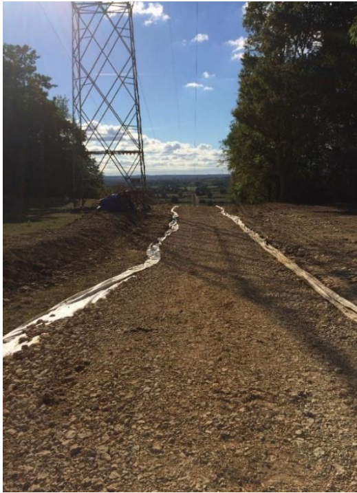
Illustration d'une piste d'accès provisoire (à gauche) et d'une plateforme d'assemblage (à droite)
