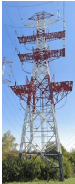
Pylône aérosouterrain
