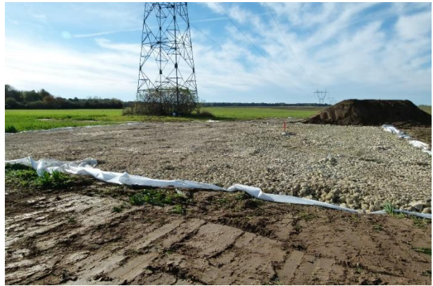
Illustration d'une piste d'accès provisoire (à gauche) et d'une plateforme d'assemblage (à droite)
