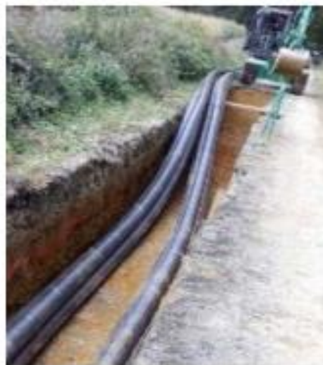
Tranchée lors de la pose d'une liaison double en PVC // Tranchée lors de la pose d'une liaison double en PEHD
