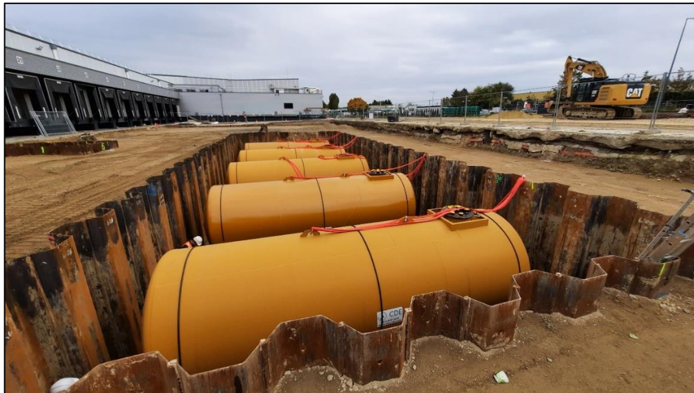
Figure 142 : Illustration de la mise en place des cuves de carburant (Phase 1)
