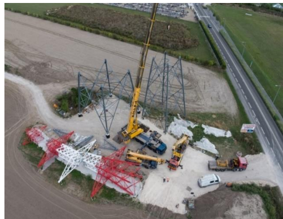
Réalisation des 4 fondations (ci-dessus) et opération de levage d'un support (ci-contre)
