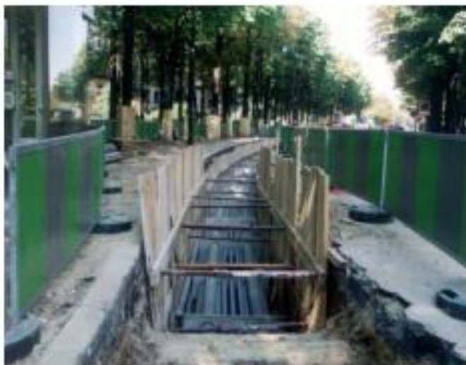
Tranchée lors de la pose d'une liaison double en PVC // Tranchée lors de la pose d'une liaison double en PEHD
