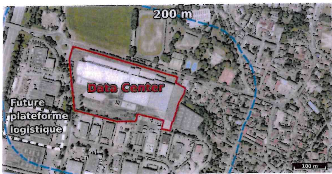
Localisation du data center (1 Boulevard Arago)
