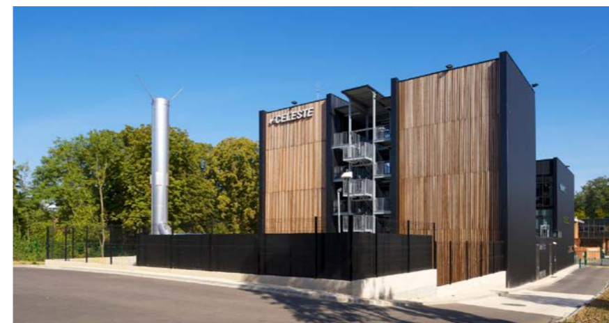
Datacenter vertical de l'entreprise Celeste en Seine-et-Marne
