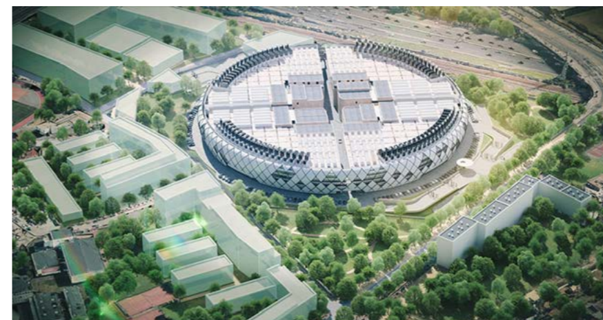
Datacenter Interxion à la Courneuve (93)
